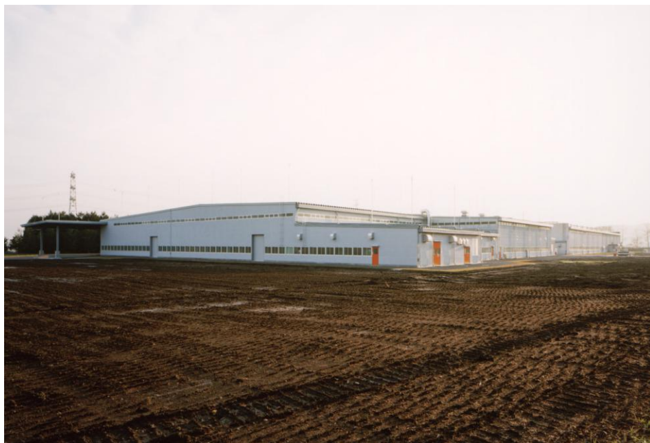
工場増築部全景（北西面）
