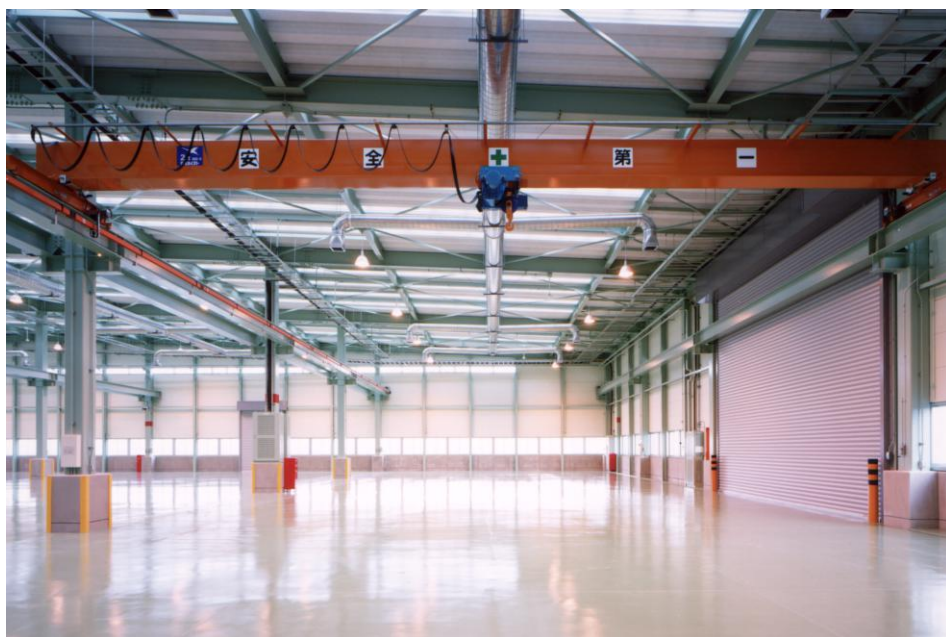
工場増築部の内部
