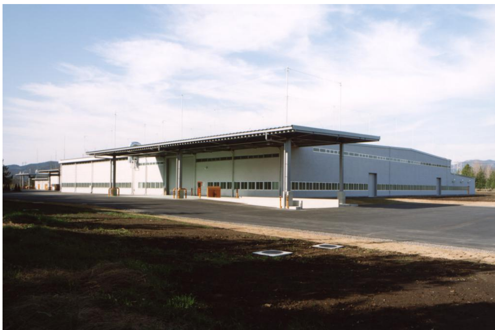
完成した栃木工場の増築部全景（北東面）
