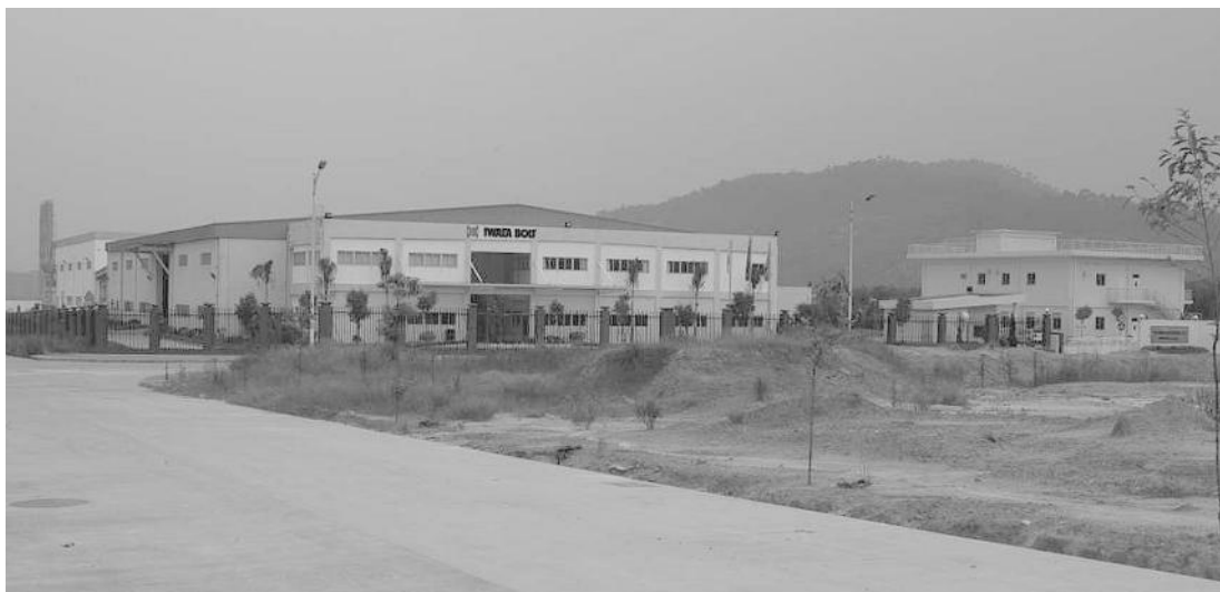
第2期工場竣工となった増築棟めっき工場(左奥)
