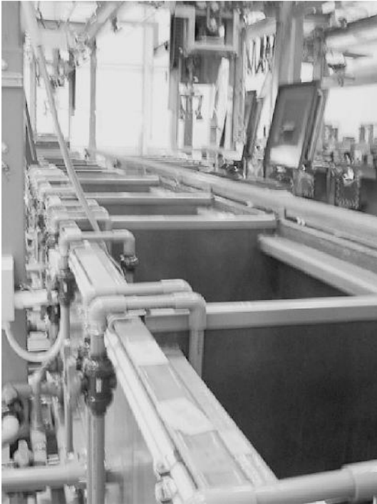
めっきライン クロメート槽
