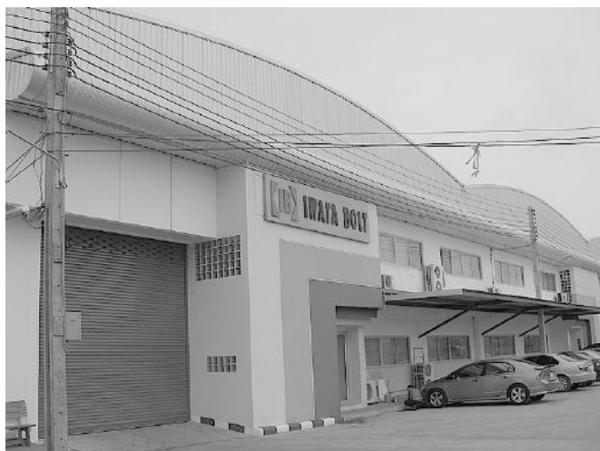
IWATA BOLT( THAILAND )CO., LTD. の新社屋
