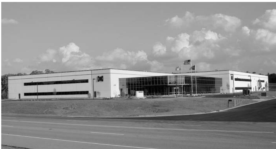
●完成したオハイオ工場全景
