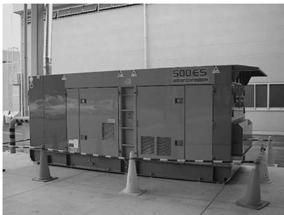
● 栃木工場に新設した500KVA能力の発電機
