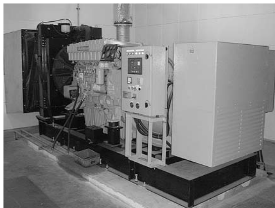
● 中国工場に増設した最新の発電機
