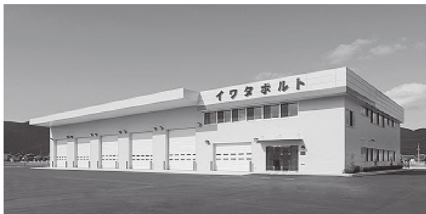
●完成したイワタボルト福岡営業所全景(敷地面積5,752㎡、延べ床面積1,841㎡)
