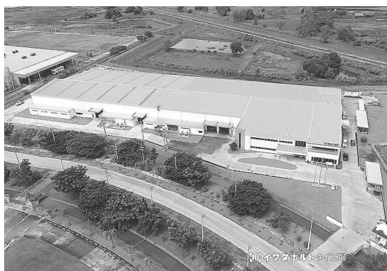
● 拡張工事を行ったタイ社屋
