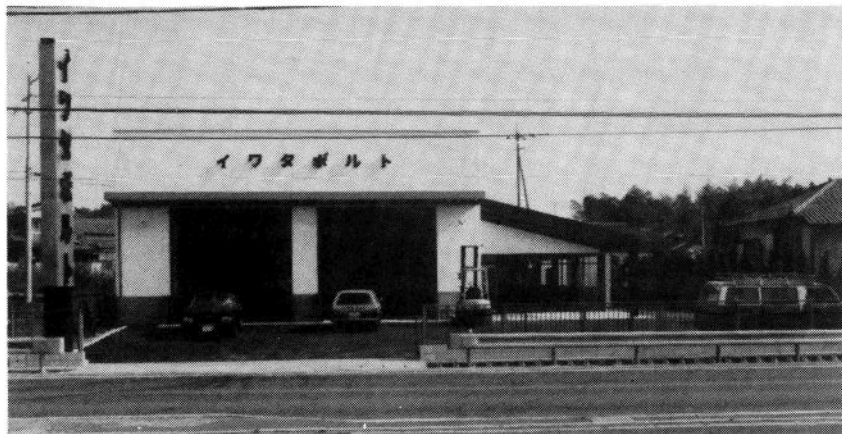
☆完成した福岡出張所の新社屋、九州地区の部品供給の体制も充実された。右は竣工式と落成披露。
