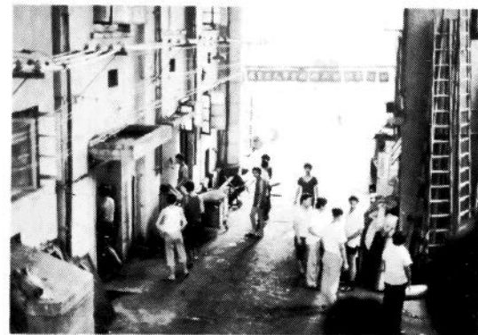
☆工場の建物に沿って高圧線が走り危険の上ない、そこまでまだ手が廻らないということか
