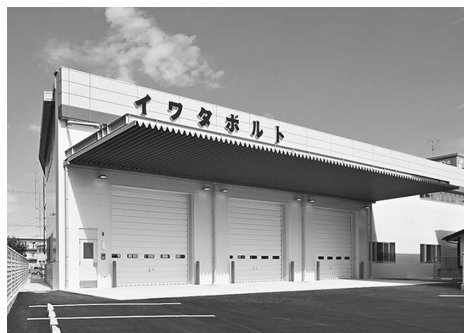
●南側：倉庫正面
